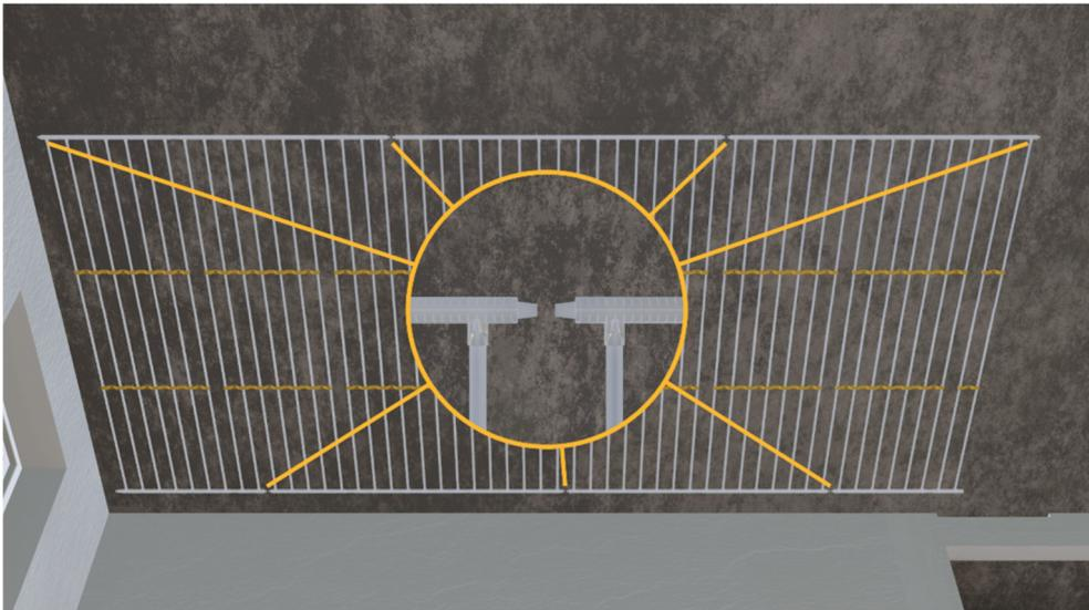
Nach dem Unterteilen in Abschnitte, werden die Sammler ebenfalls an der Decke fixiert, dazu werden Halteklammern nahe am Sammler ca. alle 50 cm eingeclipst und angeschraubt.
