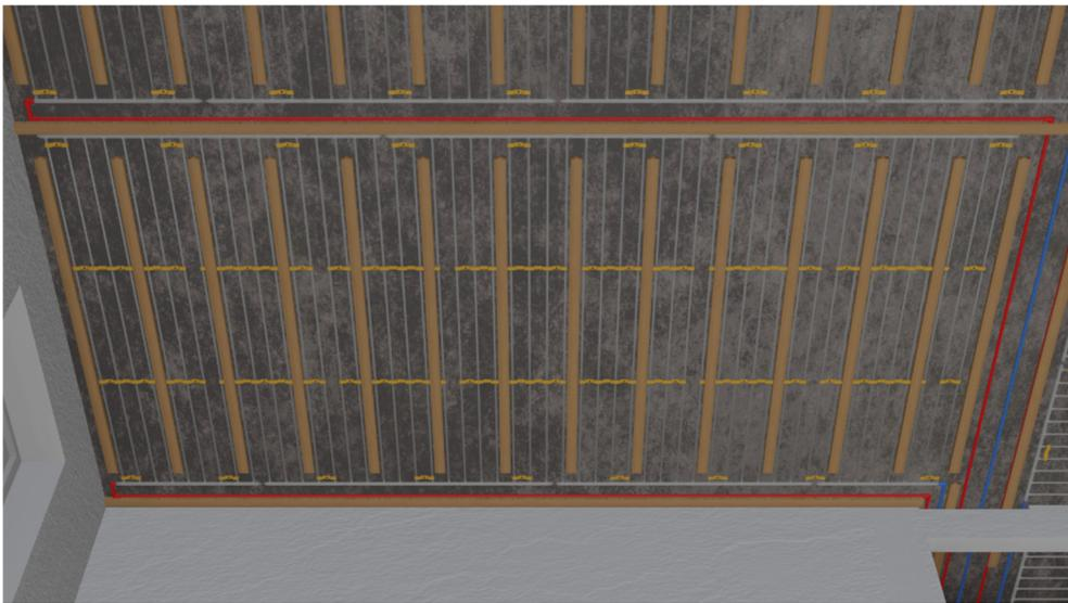
Anschließend werden die Trockenbauplatten an den Polsterhölzern montiert und verspachtelt.
