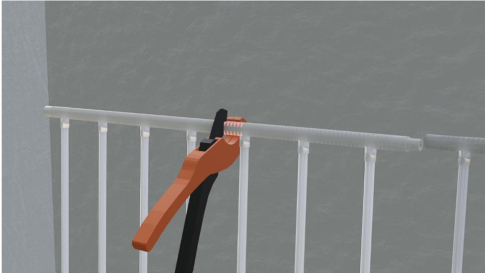
Die Sammler der Register werden nun mittels Kunststoffschweißung oberhalb der Tragprofile wieder mit einem Doppelnippel verbunden.
