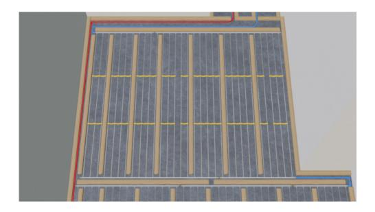
Nach Bedarf kann jetzt noch die optionale nicht isolierende Trockenschüttung eingebracht und abgezogen werden.
